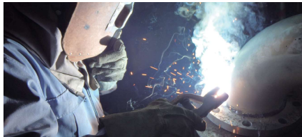
水道管の溶接例 (FAMILIARC Z-1Z 使用)
