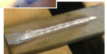
エアプラズマ ガウジング 施工例
